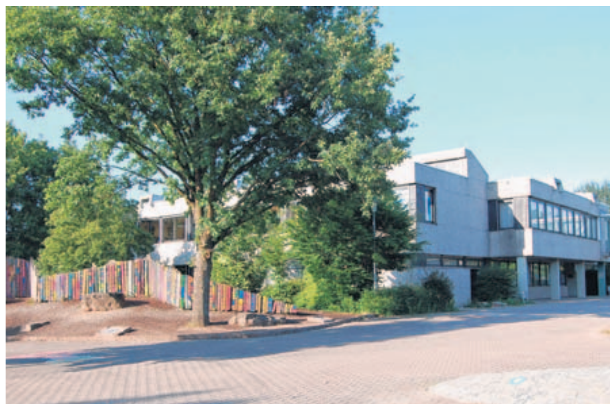
„Wir können loslegen“. Bürgermeister Roland Burger gab mit diesen Worten am Montag im Gemeinderat den Startschuss für den Umbau der Karl-Trunzer-Hauptschule mit Werkrealschule in eine Ganztagschule.
